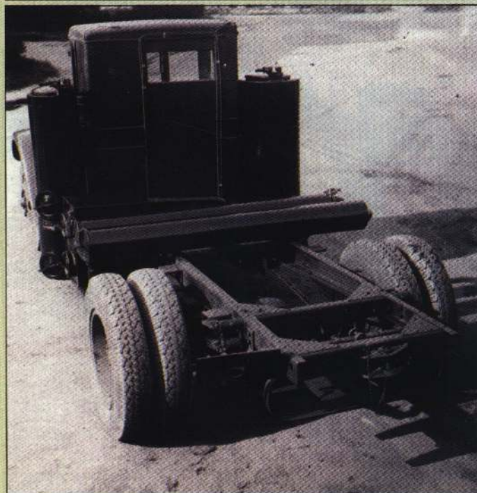
ГАЗ-АА с газогенератором НАТИ-Г21А без кузова
